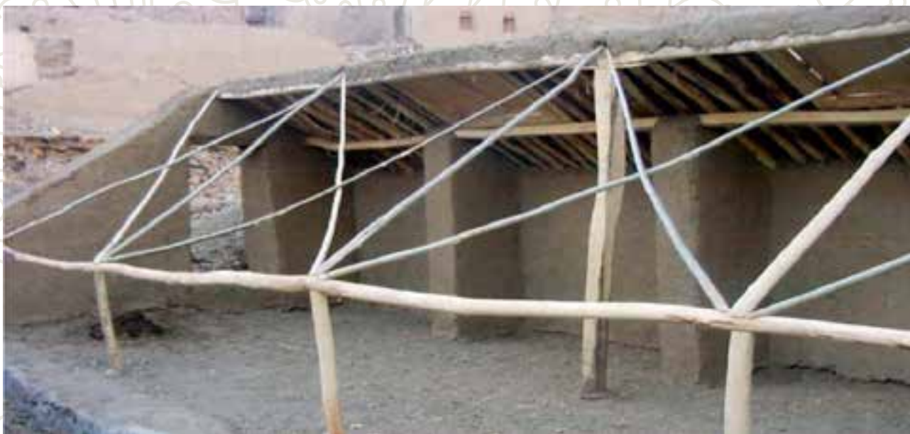
تصویر 10-: ساختمان داخلی گلخانه - پایه چوبی افقی عمده توسط پایه های چوبی حمایتی می‌گردد و تیر یا دستک چوبی افقی دوم توسط دیوار های قسمتی که در داخل گلخانه وجود دارد حمایت گردیده است.
