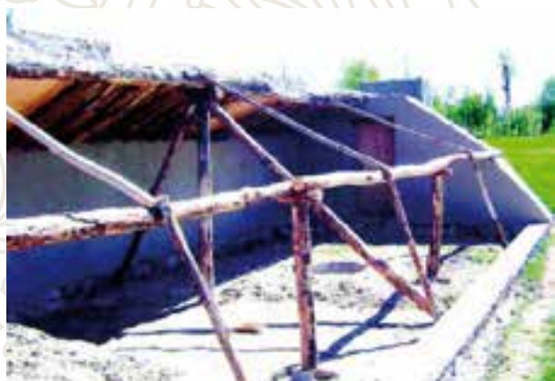
تصویر 13-:- اسکلت تنظیم شده و آماده برای هموار کردن فلم پلاستیکی یا شیت پولی اتلین
