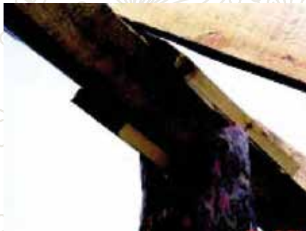
تصویر 9-: پایه حمایتی عمودی ، پایه چوبی افقی در قسمت که باهم متصل گردیده اند.
