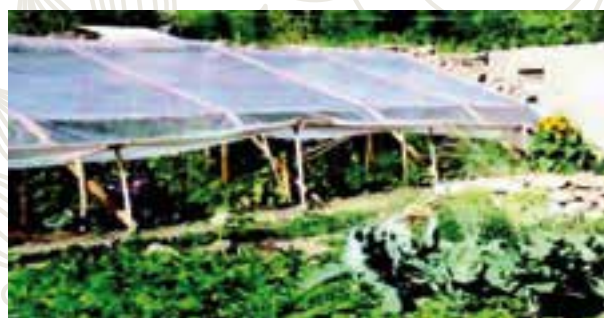
تصویر - 16: سیستم تهویه تابستانی گلخانه با استفاده از بلند کردن قسمت تحتانی پلاستیک یا شیت پولی اتلین
