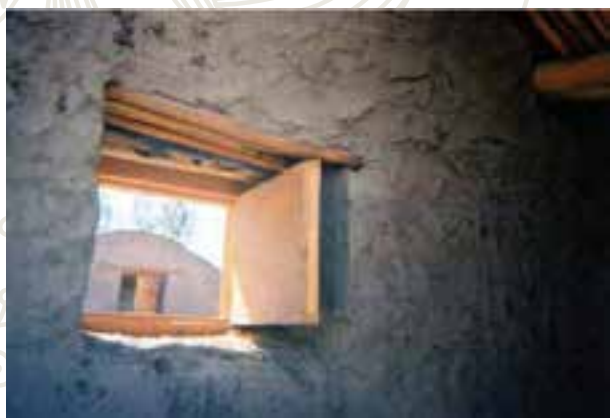
تصویر 7- : نصب دریچه های تهویه در دیوار
