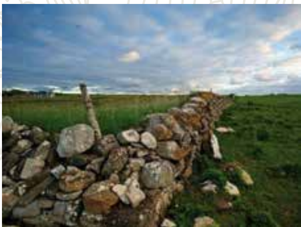
شکل 3- حصار بندی توسط دیوار های سنگی همراه با سیم های خار دار و پایه های چوبی
