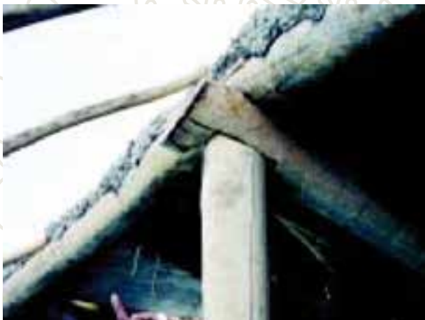
تصویر 8-: پایه حمایتی عمودی پایه چوبی عمده افقی
