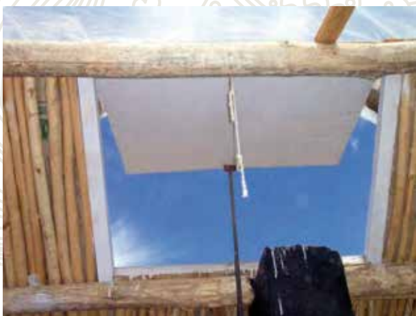
۱۰- ډنډه- د هوا د بهير د سيستم داخلي شکل چې نصب او خلاص شوی دی.
