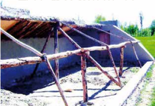
۱۳- بڼه - د پلاستيکي فلم د هوارولو له پاره ترتيب شوی او چمتو شوی اسکالېټ
